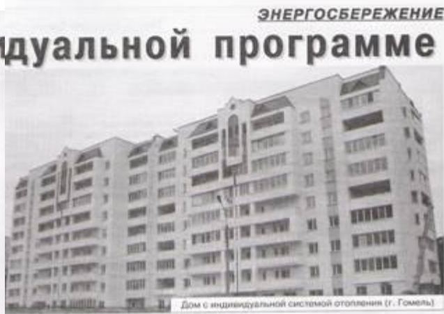
Дом с индивидуальной системой отопления (г. Гомель)
